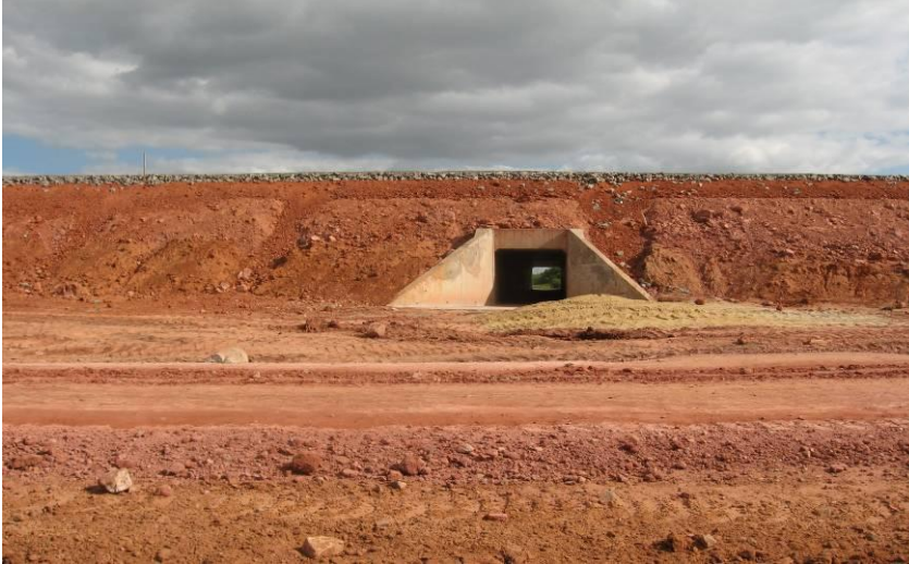
Figura 05 - Passa-fauna, km 3+200, BR-448, Rodovia do Parque, note estrada lateral à pista principal.
