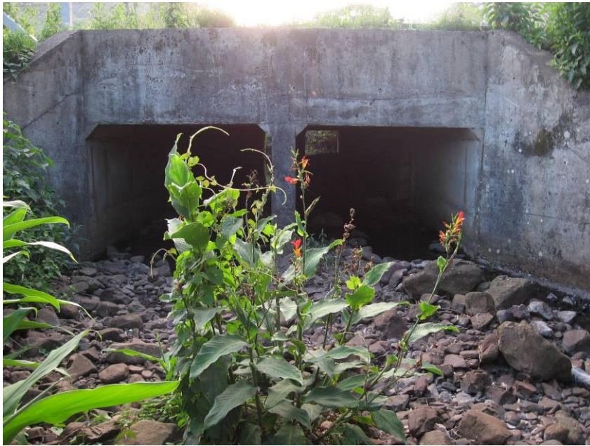
Figura 11 - BR-101, km 79,9, Osório – RS, galeria e passa-fauna.
