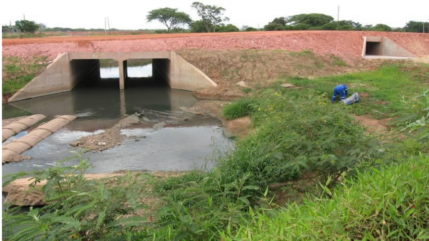
Figura 03 - Conjunto de passa-faunas km3+200, Rodovia do Parque, acesso da BR-448.
