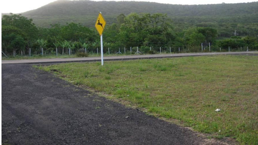
Figura 15 - BR-101, km 79,9, Osório – RS, vista da rodovia , tela com 60 m para cada lado do passa-fauna, note placa indicativa de passagem de animais na pista.
