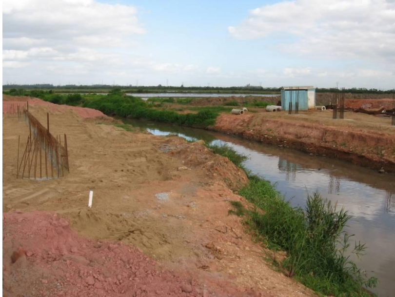
Figura 09 - Futura Ponte, no Arroio Sapucaia, km 7+300, BR-448. Note ferragens da estrutura da ponte e o espaço destinado à passagem de animais.
