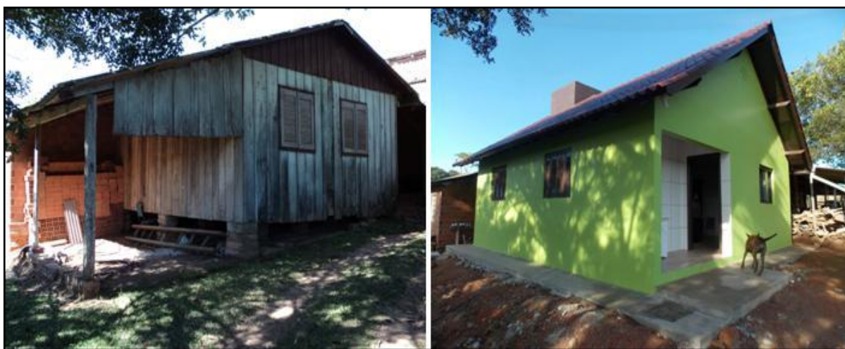
Figura 2 - Santa Cruz do Sul – situação da unidade habitacional
