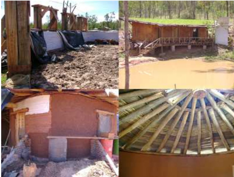
Figura 2: Bioconstruções em Superadobe e Terrapalha com telhado vivo.
