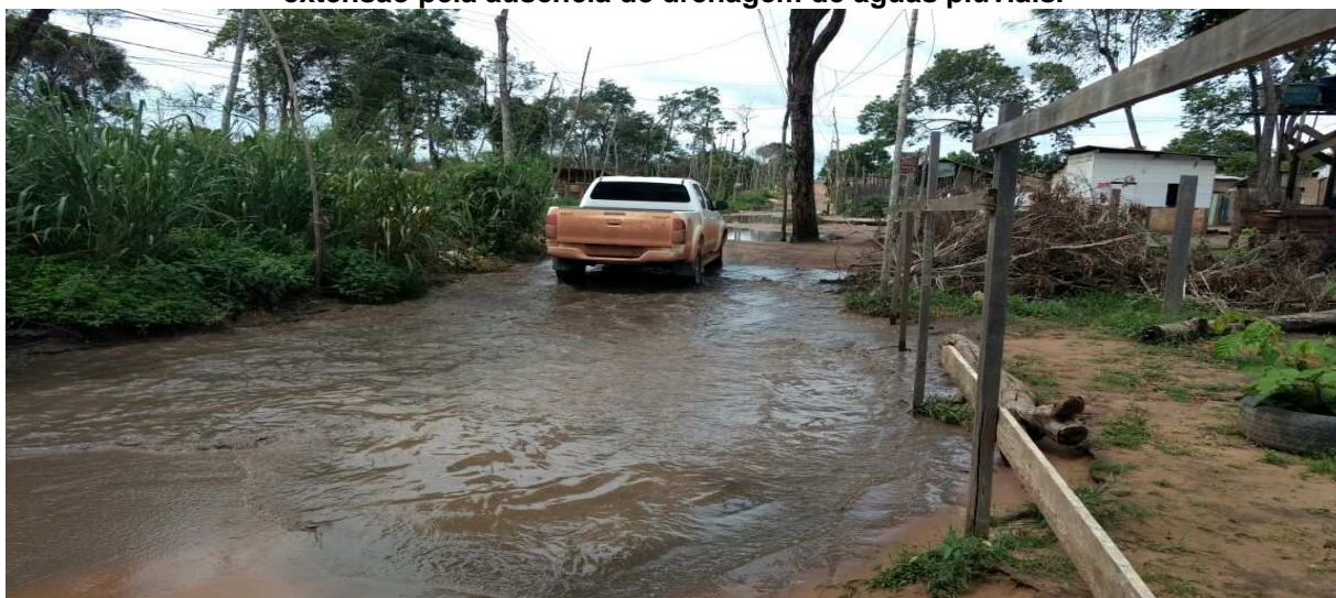
Figura 2 – No período de chuvas as ruas ficam inundadas ou com poças d'água em sua extensão pela ausência de drenagem de águas pluviais.
