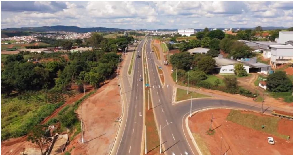
Figura 2. Vista aérea do novo trevo Aeroporto/Porto Seco/Cidade Universitária.
