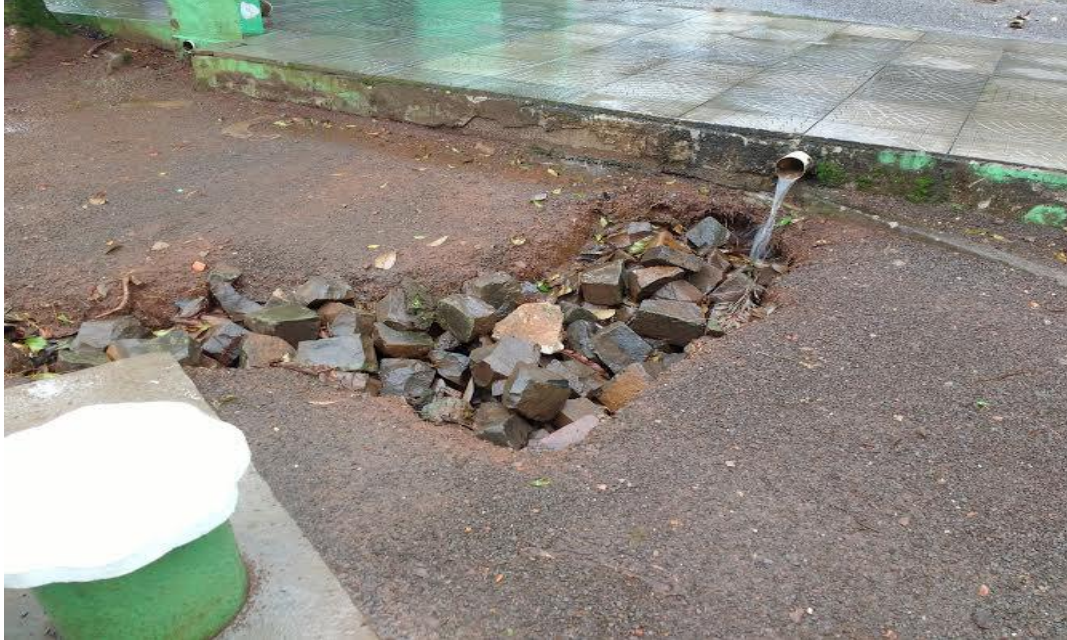
Figura 7 - Dreno construído e em funcionamento no pátio da Escola
