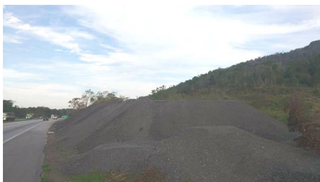
Figura 2 Depósito na faixa de domínio na PR-407
