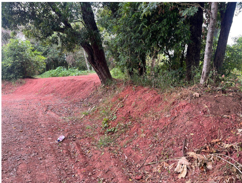
Figura 3 - TAIPAS FEITAS NO BAIRRO VÁRZEA PARA IMPEDIR A ENTRADA DA ÁGUA
