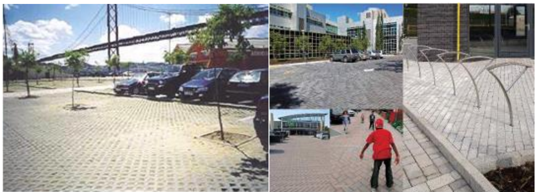
Figura 2: Pavimentos intervalados por gramíneas e Pavimentos intervalados. Fonte: Rossana Lourenço. Sistemas Urbanos de Drenagem, 2014, p. 57-58.
