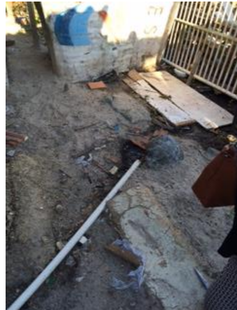
Figura 4: Esgoto a céu aberto na Comunidade Vila do Arvoredo – 25 de ago. 2016.
