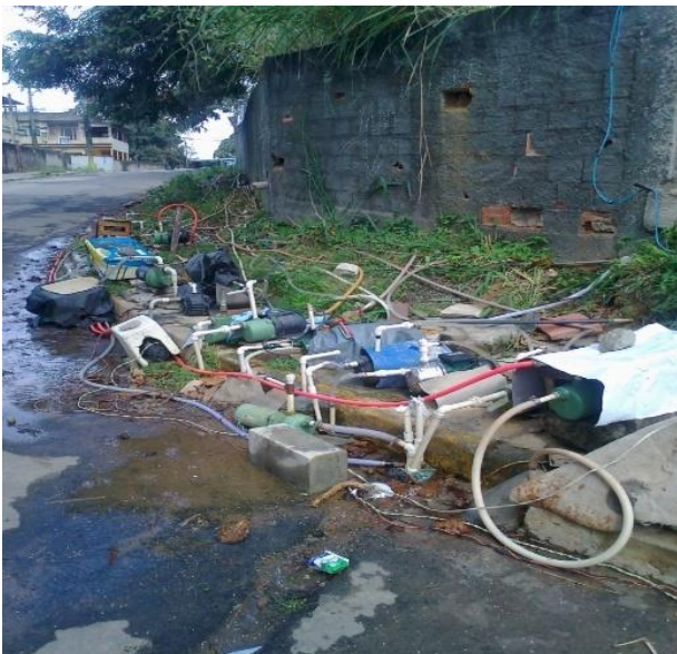
Figura 3: Esquina da Localidade COHAB – Cemitério das Bombas (denominação dos moradores). Subárea Central.
