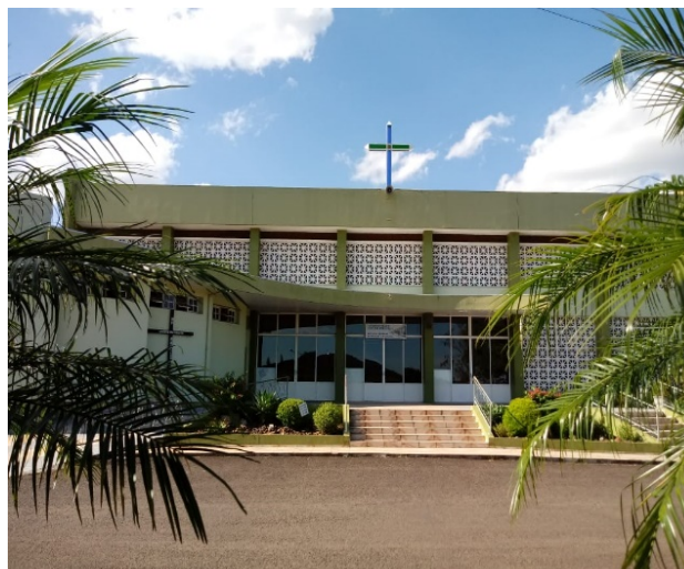
Imagem 07: Identificação dos vitrais na Fachada Frontal
