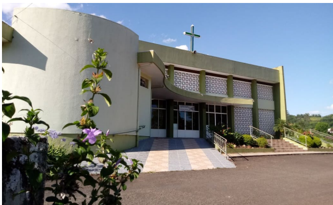
Imagem 03: Vista da Igreja Atual
