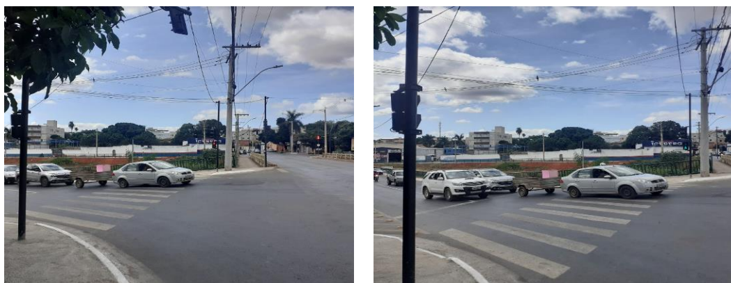
Figuras 11 e 12 – Obra de revitalização da Av. Vicente Guimarães
