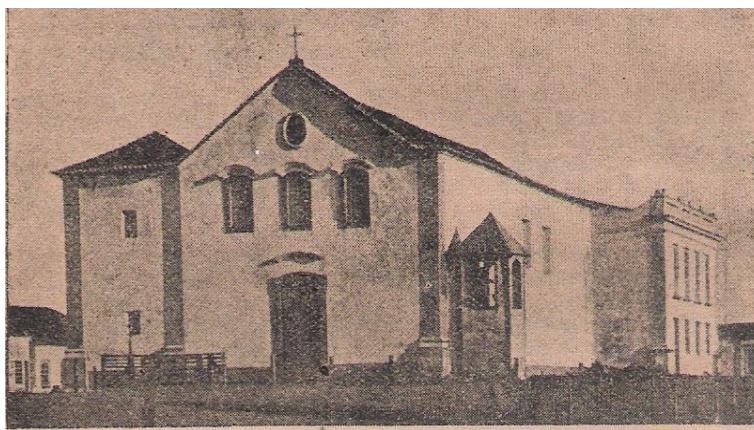
Figura de nº4 - Matriz São José antes da construção da torre
