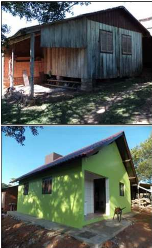
Figura 2 - Santa Cruz do Sul – situação da unidade habitacional
