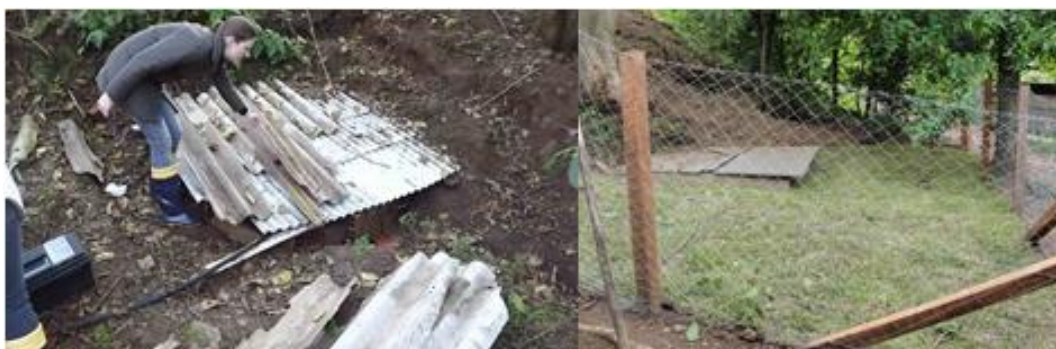
Figura 4. Nascente antes e depois da realização das benfeitorias.
