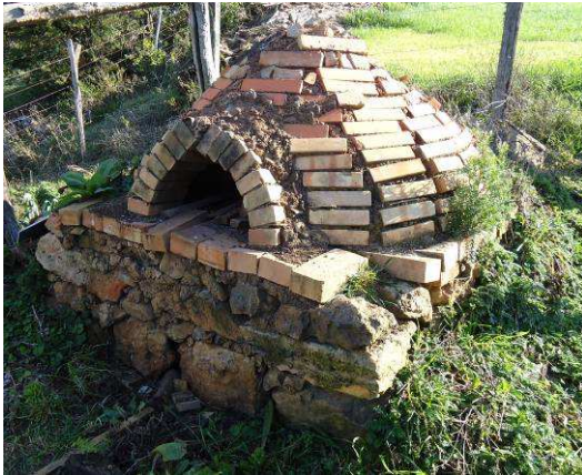
Forno atual construído com tijolo
