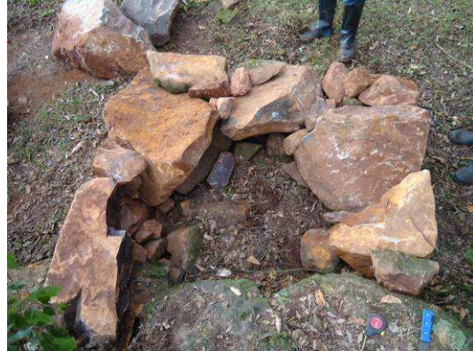
Início da construção com a colocação dos blocos
