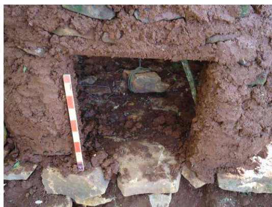
Levantamento das paredes utilizando barro amassado Abertura frontal do forno (porta).
