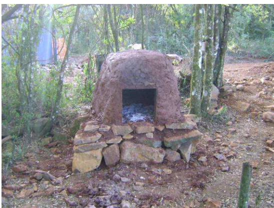
Forno pronto após a queima para secagem das paredes
