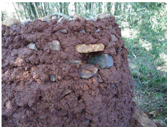
Pequena abertura na parte superior do forno que serve como chaminé
