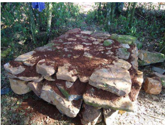
Base pronta para receber as paredes do forno
