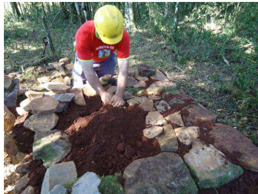
Preparação da base do forno
