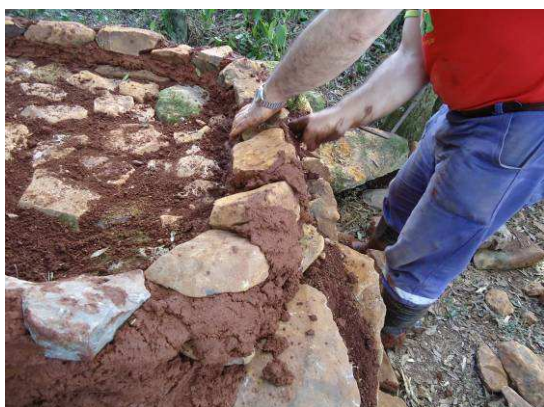
Levantamento das paredes utilizando barro amassado Abertura frontal do forno (porta).
