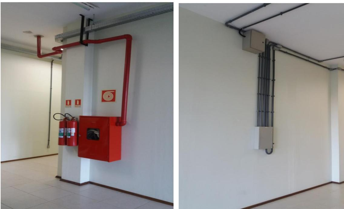
Figura 10. Hidrantes, extintores de incêndio e quadro de painéis no prédio.
