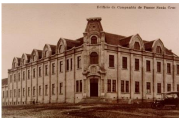
Edificação original da Companhia na esquina das ruas Borges de Medeiros e Ernesto Alves. Ano de 1923
