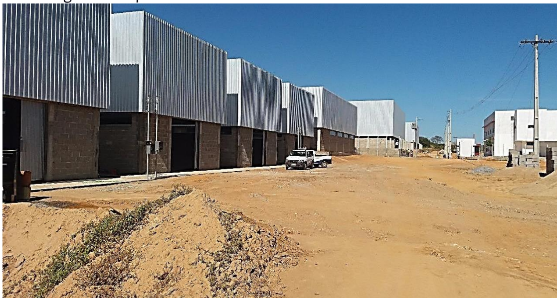
Figura 1 - Galpões construídos no Distrito Industrial José Leão Pereira
