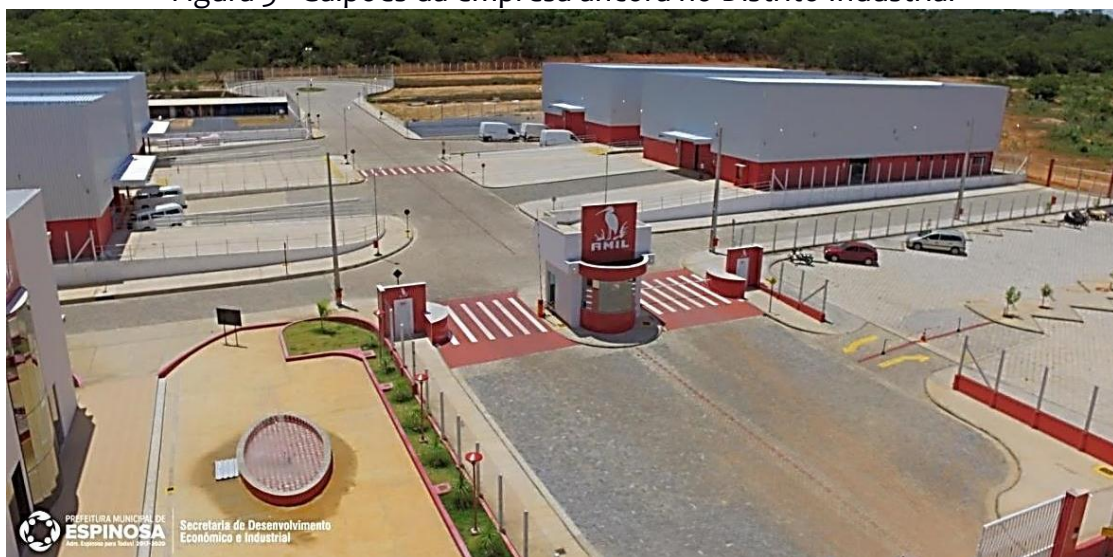
Figura 3 - Galpões da empresa âncora no Distrito Industrial
