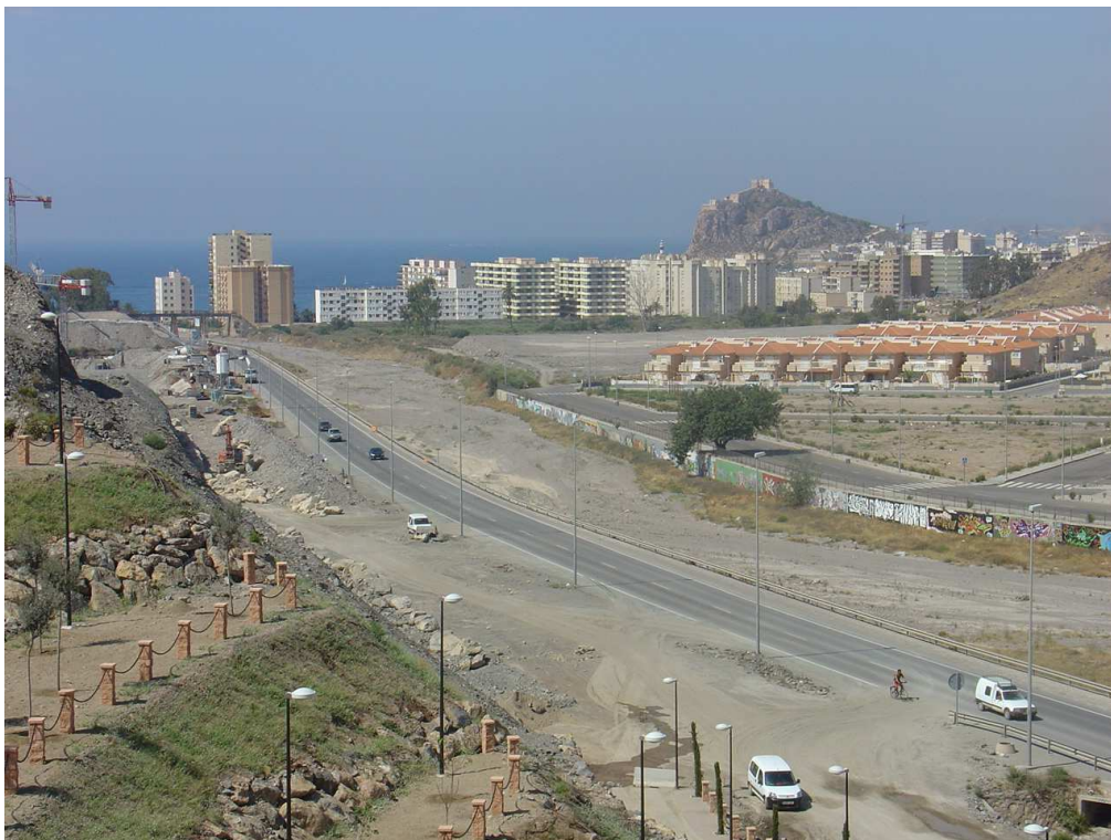
Figura 2. Ejemplo de urbanización en zonas inundables, Águilas (Murcia). En su tramo final el lecho de inundación de la Rambla de las Culebras está siendo objeto de una continua ocupación por viviendas residenciales
