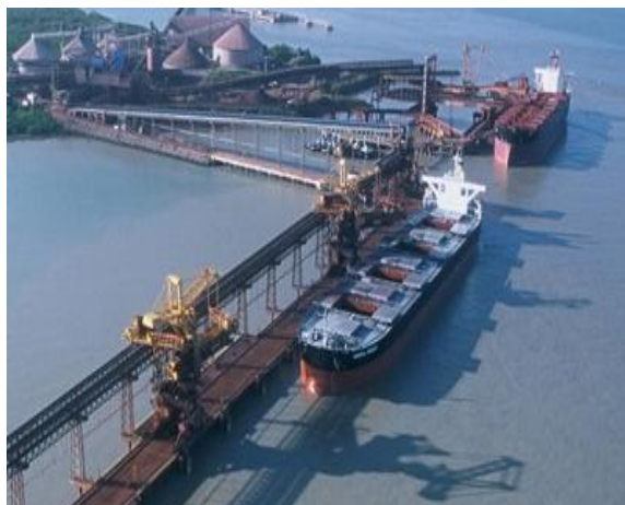
Figura 8- Pier 3 e Pier 1 (ao fundo) [38]
