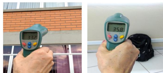
Figura 2 – Registros externo (esquerda) e interno (direita) na edificação convencional (18h)
