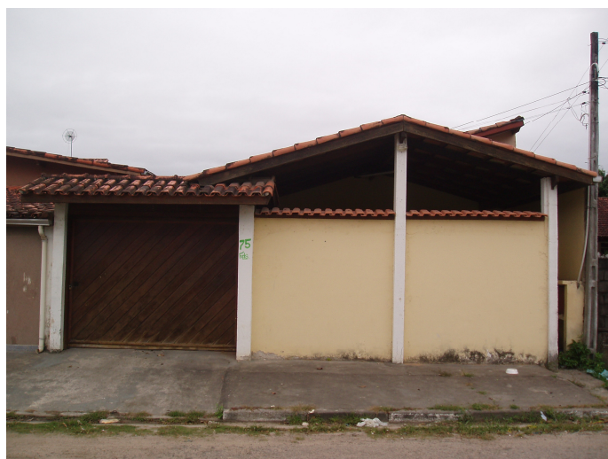
Figura 11 – Exemplo de edificação geminada
