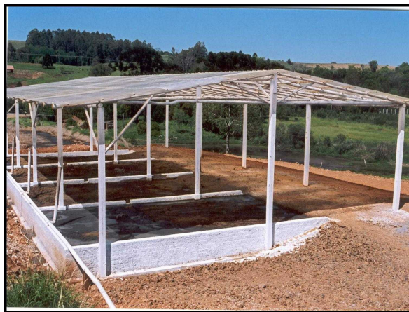
Figura 1. Tanques de alvenaria, impermeáveis, com substrato impregnado com dejetos (Fonte: Dai Prá).
