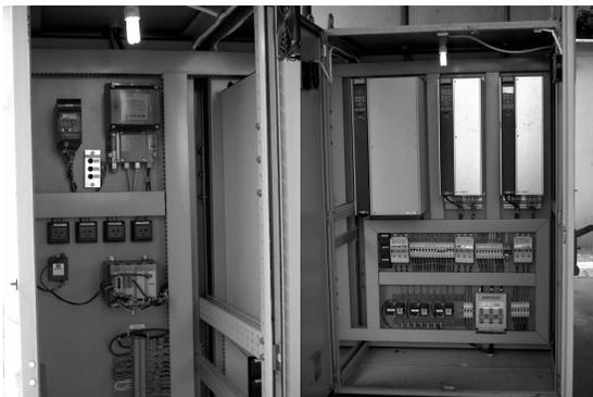
Figura 5. Painel elétrico para montagem dos dispositivos de proteção, conversores, CLP, medidores de vazão e de nível.
