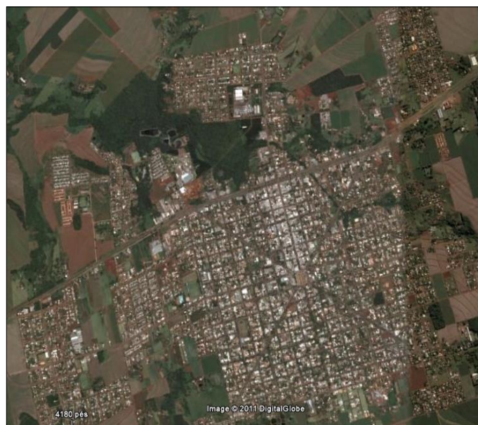
Figura 1 Vista aérea do Município de Medianeira – PR Fonte: Google Earth (2011)
