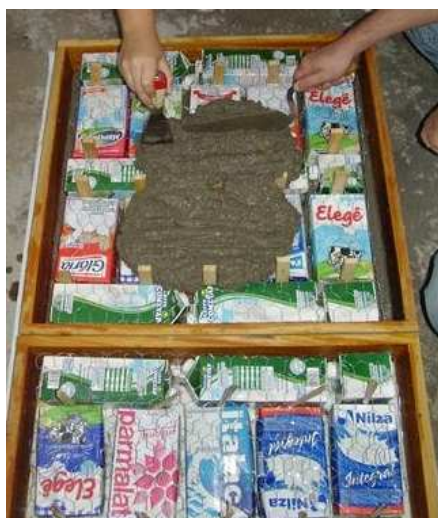
Figura 2 – Lançamento da argamassa na forma com o posicionamento de espaçadores
